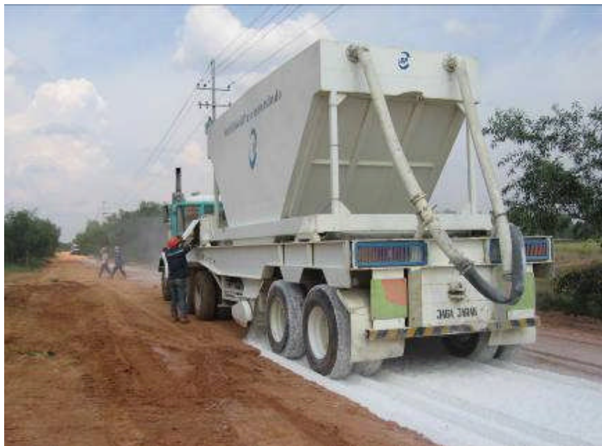
Gambar D.2 - Penyebaran bahan pengikat ( spreading )
