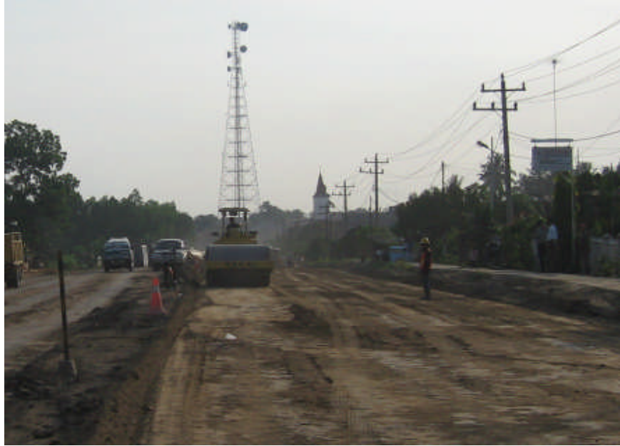
Gambar D.7 - Pemadatan akhir ( final compaction )
