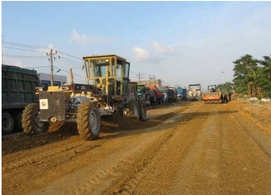
Gambar D.6 - Pemotongan ( triming )
